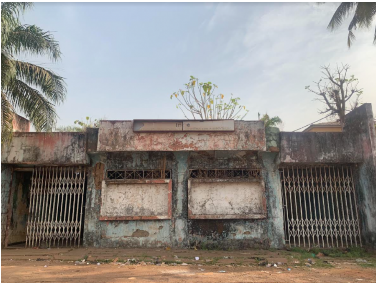
Budova INCA, únor 2024
