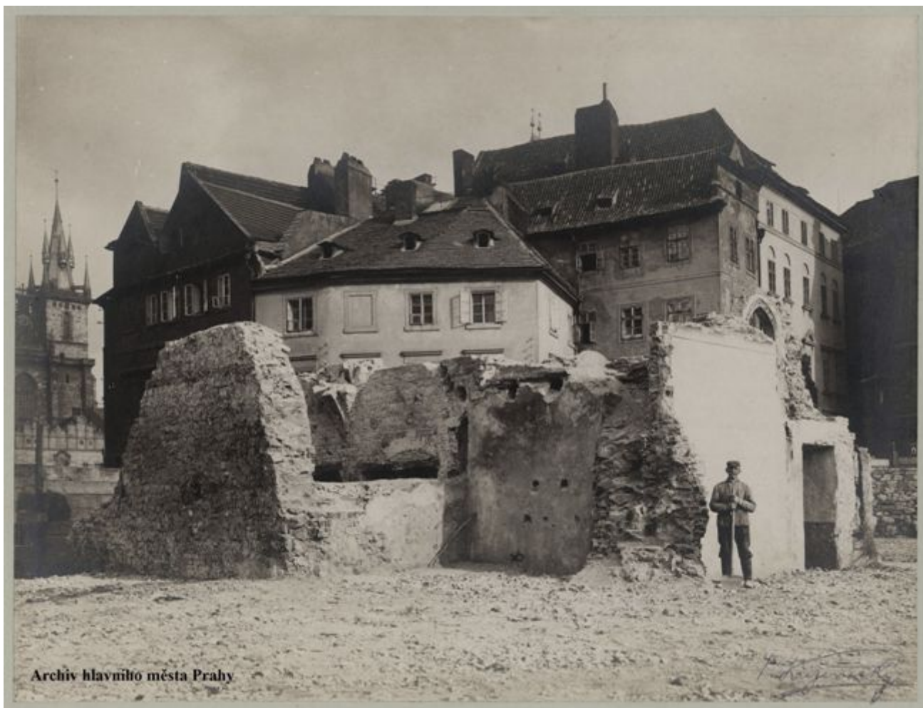
Pohled na zbytky románského zdiva nalezeného při bourání domu čp. 16 v ulici U radnice na Starém Městě, 3. 4. 1909 (foto: Archiv hlavního města Prahy)
